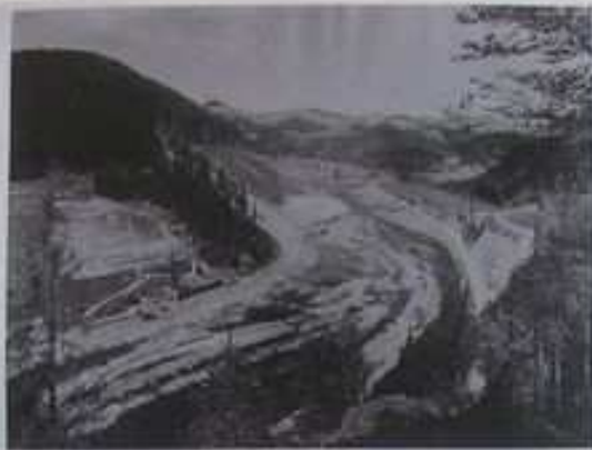
BETONOVANÍ PRVNÍCH BLOKŮ HRÁZE
