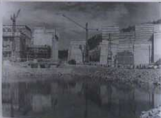
BETONOVANÍ PRVNÍCH BLOKŮ HRÁZE
